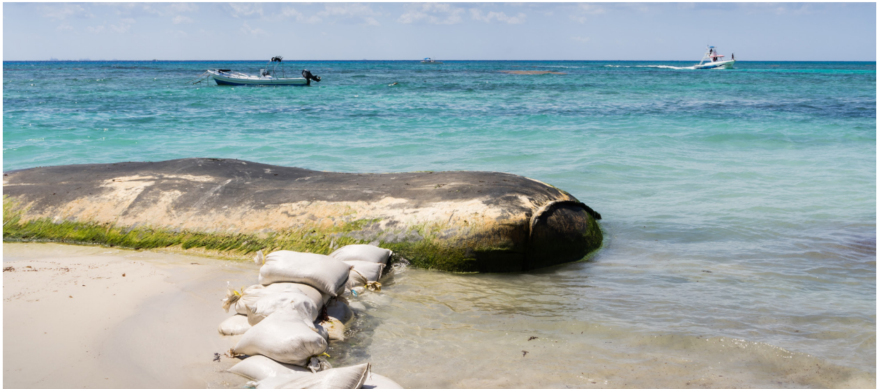
Figura 50 Geotubos en zona de playa (Tomado de Geosolutions)
