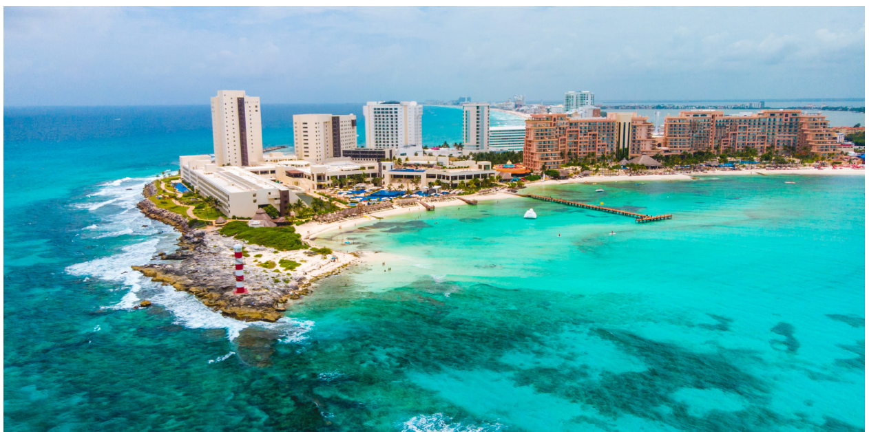
Figura 10 Playa apoyada por estructura artificial. Punta Cancún. Playa de Cancún, Quintana Roo, México
